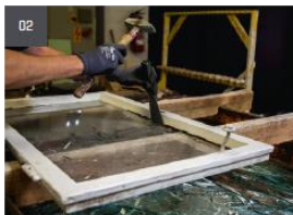
02 Entglasung der Flügel im Werk und Entfernung der Bestandsbeschläge
