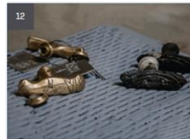
12 Überarbeiten und Reinigen der Beschläge
