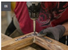
06 Nachbefestigen der Eckwinkel zur Stabilisierung der Eckverbindung
