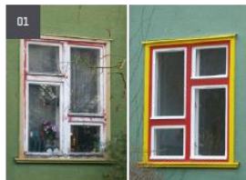
01 Ganzheitliche Überarbeitung eines Kastendoppelfensters
