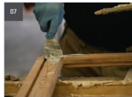
07 Schließen offener Brüstungsfugen und Risse im Holz
