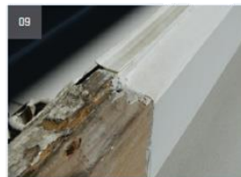
09 Einbau der Schiagregendichtung am Blendrahmen vor Ort
