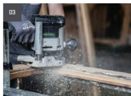
03 Nachfräsen der Glasfalte nach der Entglasung
