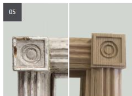
05 Aufarbeitung oder Ersatz nicht intakter Holzteile
