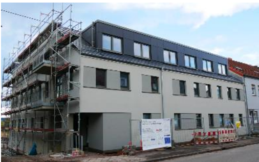
Neubau Herrenstraße 33-37, Saarlouis, Saarland, Schwerpunkt: Barrierefreies Bauen
