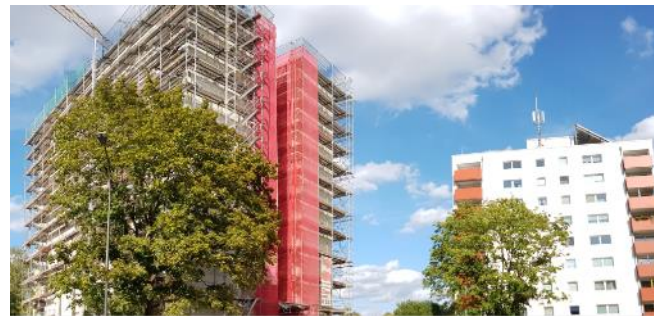
Renovierung Fasanenallee 4 + 6, Saarlouis, Saarland, Schwerpunkt: Energieeffiziente Sanierung
